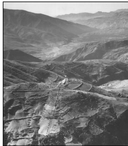
Cable aéreo y estación intermedia
